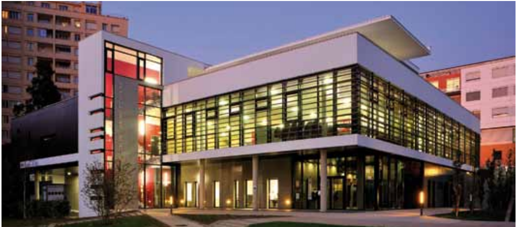
Restaurant universitaire, Lyon-Saint-Étienne, X'TO architectes.
