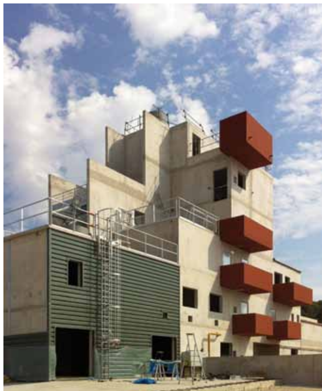
Simulateur d'incendie type Maison à feux, École Départementale de Sapeurs-Pompiers, SDIS 13, Velaux , Ivan Franic et Michel Garcin.
